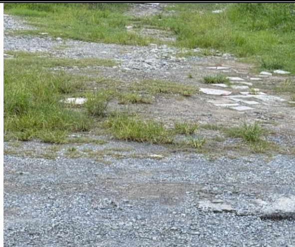
Hình ảnh hiện trạng tại ô đất OCT3
